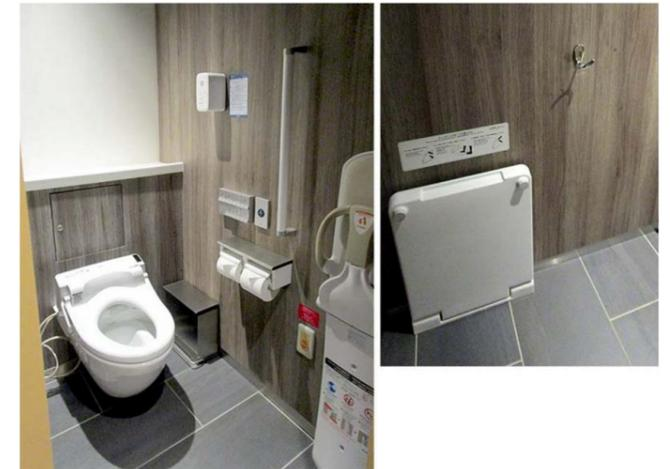
壁掛大便器とボタンを押すと発電し電源が不要なエコリモコンを搭載したウォシュレットを採用。お子様連れの利用や着替えに対応できるように、すべてのブースにベビーチェアとフィッティングボードが設置されている。
