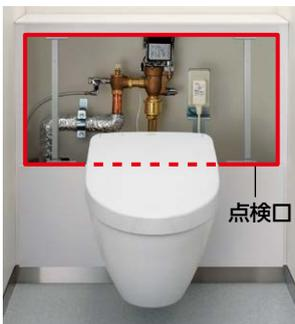
前面または上面の点検口を外して、フラッシュバルブなどの内蔵器具のメンテナンスもラクにできます。
