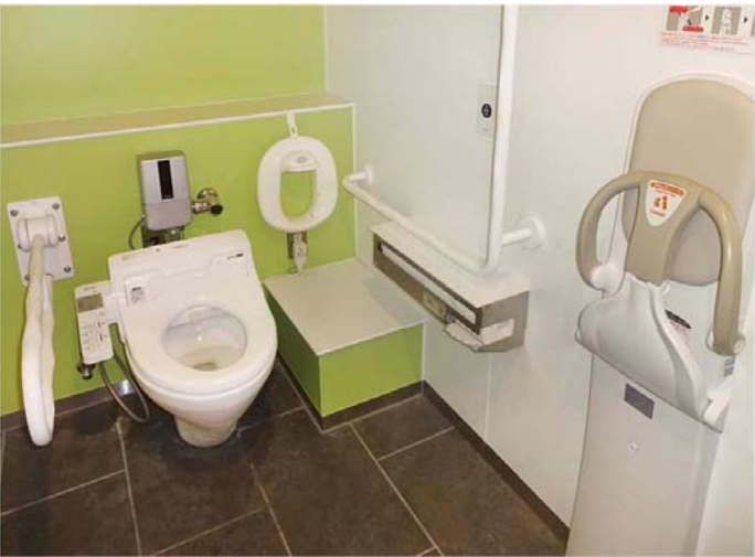
男性トイレのブース内にも、お子様連れ配慮として、ベビーチェアを設置したひろびろブースを設けている。幼児用おまる（補助便座）も常備している。
