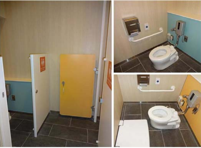
保護者がトイレブースの外から見守りができるように、低めの壁で仕切られている。手すりや着替えのためのフィッティングボードも設置している。
