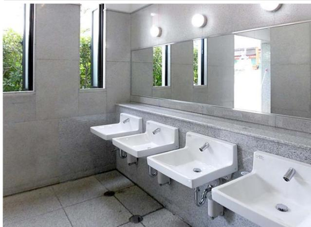
窓から自然光が差し込む明るい洗面コーナー。鏡下には手荷物がおけるカウンター部を設けた。水栓金具は水じまいがよく、ノンタッチで水の出し止めができる壁付きの自動水栓を採用している。
