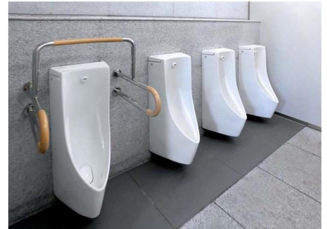
床の清掃性に優れた壁掛式の自動洗浄小便器を採用。ライニングが石造りのため、正面からメンテナンスが可能な掃除口付きタイプを設置している。1ヶ所には、小便器用手すりを設置。
