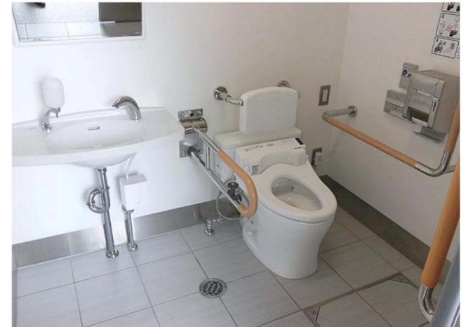
背もたれや手すりを完備した車いす使用者配慮トイレ。便座には、ボタンを押すたびに発電する電源不要のエコリモコンを採用した、ウォッシュレットPSを設置している。
