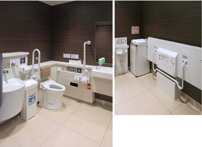
必要な設備がパッケージされたコンパクト多機能トイレパックを採用。さまざまな使用者に配慮して、オストメイト対応トイレパック・収納式多目的シート・ベビーチェア・おむつ用ダストボックスを完備している。
