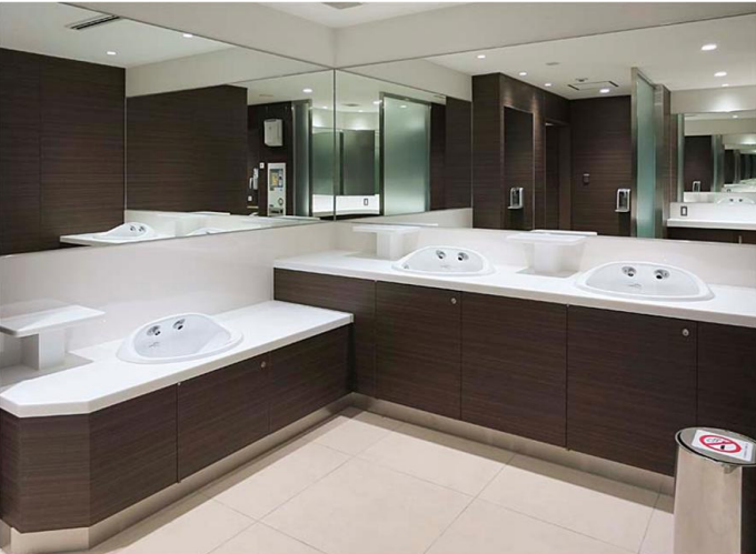
洗面器は手洗いから乾燥まですべて洗面器ボウル内で行えるオートボウル（自動洗面器）を採用。1ヶ所の洗面器はお子様が使いやすい高さに設置。カウンターの上面には荷物棚を設けている。
