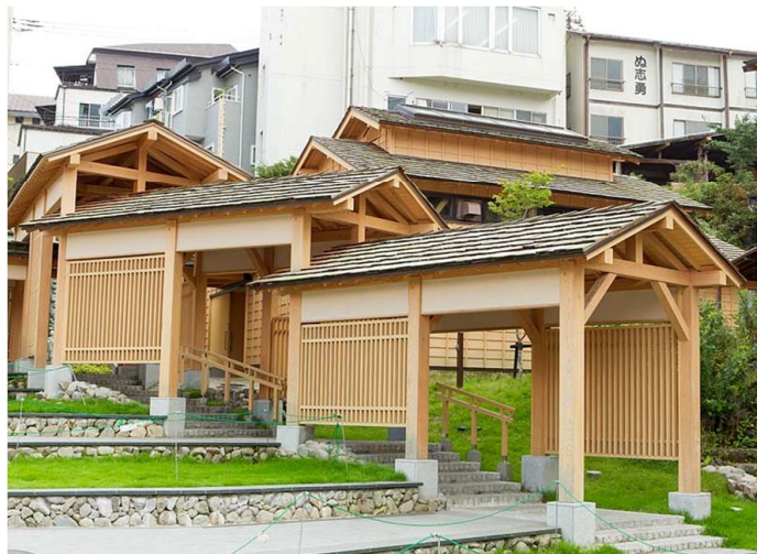
回廊の奥に見えるのが、湯路広場のランドマークとなるトイレ棟。木回廊とトイレ棟の屋根は、湯路広場のコンセプトである「昭和レトロ」を具現化した板葺き屋根となっている。
