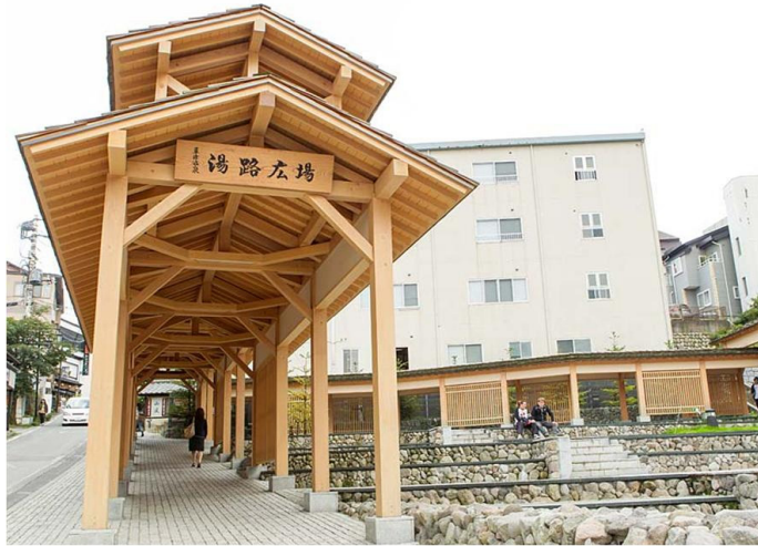
宿泊客が浴衣姿でそぞろ歩くことができる回廊。通路のピンコロ石の下には、冬の融雪のため温泉が通っている。
