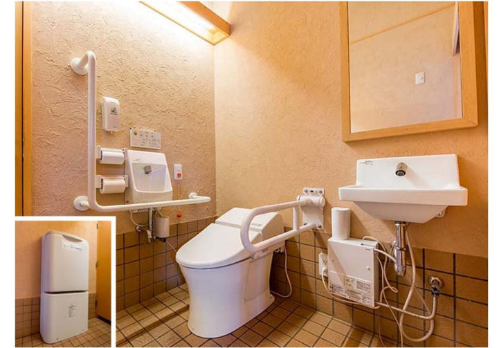
車いす使用者のほか小さなお子様連れにも配慮して、ベビーシートを備えた多機能トイレ。
