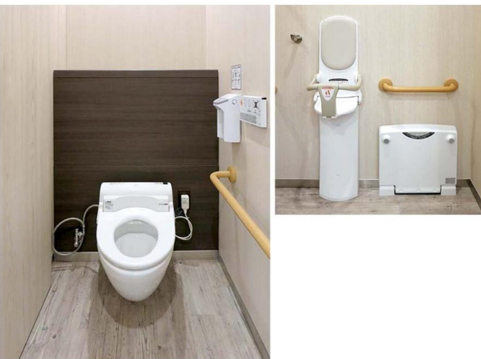
男性トイレ 大便器ブース
