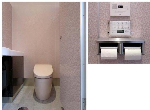
女性トイレの大便器は清潔感を重視し、「きれい除菌水」の機能を備えたネオレストAHを採用。男性トイレ同様、たばこなどによるいたずら防止のため、リモコンにはアクリルのカバーを取り付けている。
