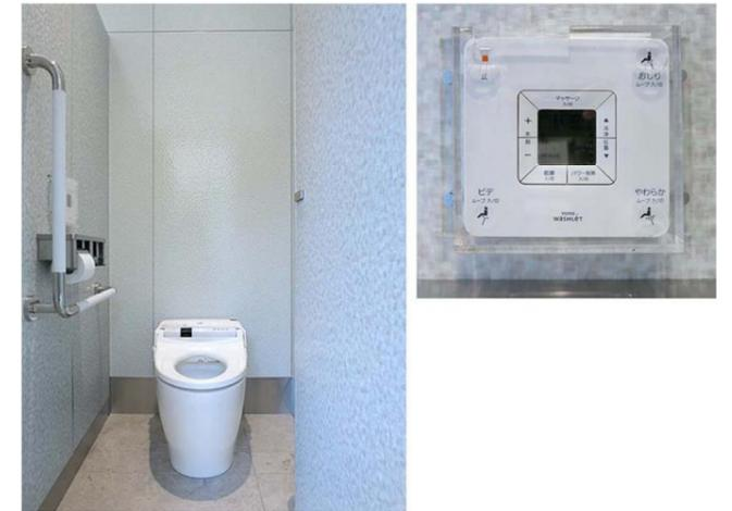
大便器はウォシュレット一体形便器ネオレストDのフタなしタイプを採用。たばこなどによるいたずら防止のため、リモコンにはアクリルのカバーを取り付けている。
