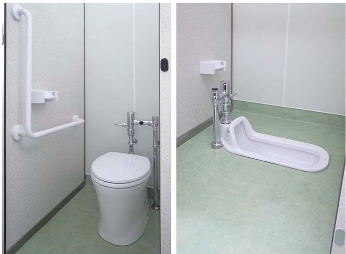
洋式便器のブースにはL型手すりを設置（前出寸法：90mm）。和式便器は1ヶ所設置。
