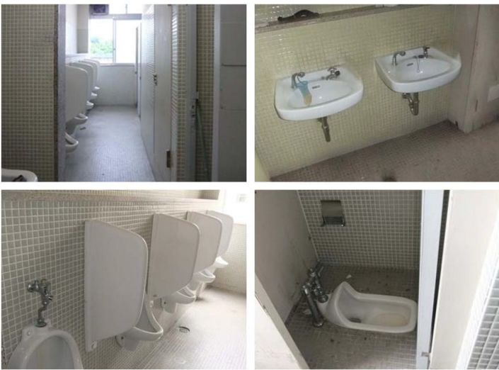
改修前は和式便器のみで、清掃方法は湿式清掃を採用していた。
