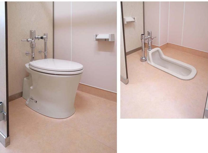
洋式便器のブースの1ヶ所にはL型手すりを設置（前出寸法：90mm）。和式便器は1ヶ所は設置。
