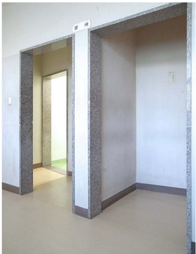
トイレ入口は改修せず従来のまま。トイレの床材はタイル張りから長尺シートに変更。
