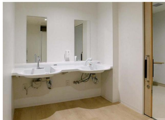
車いすのまま使用可能な車いす対応洗面を採用。配管やコードは、車いすのフットレストに干渉しない上部に設置し、足元スペースを確保している。水栓はホース付きタイプの手動と自動の2種類を設置している。
