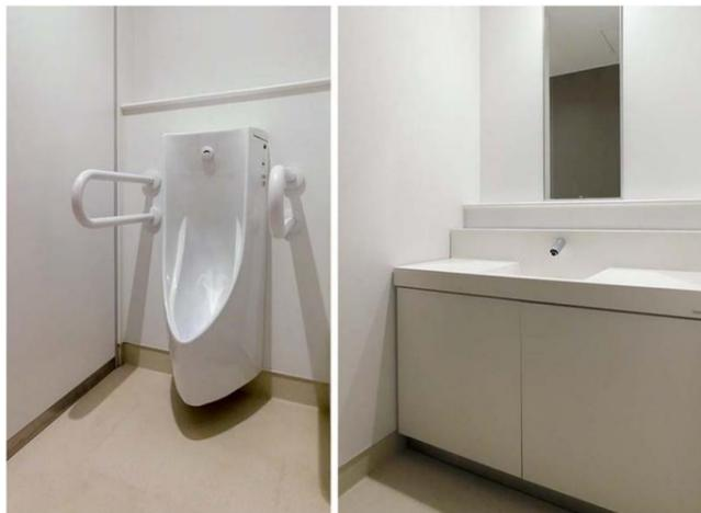
小便器は、高齢者の方にも使いやすく、床の清掃性に優れた低リップタイプの壁掛自動洗浄小便器を採用。洗面は、水濡れを心配せずに手荷物を置けるツインデッキカウンターを設置している。
