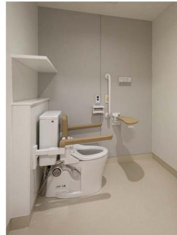
大便器には、座位の安定をサポートする背もたれと手すりを採用。さらに、便器移乗時の動作・姿勢の安定が図れる前方ボード(スイングタイプ)を設置し、転倒リスクや介助者の負担を軽減している。
