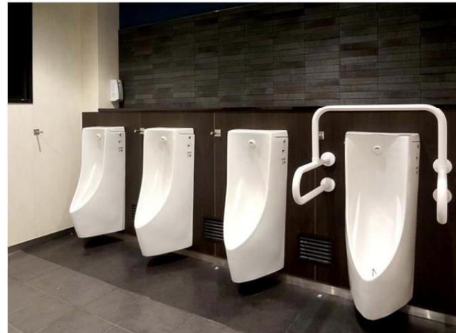
尿石制御・節水システムを搭載した自動洗浄小便器を設置し、足元には防汚・防臭機能を備えたハイドロセラ・フロアを採用している。また、荷物配慮として棚やフックを設けている。
