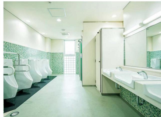
壁掛自動洗浄小便器は自己発電・節水タイプ。足元にはハイドロセラ・フロア・PUを設置し、汚れやニオイの発生を抑えている。洗面器は手洗い位置がカウンターより下になり、水はねしにくいボウルを採用している。
