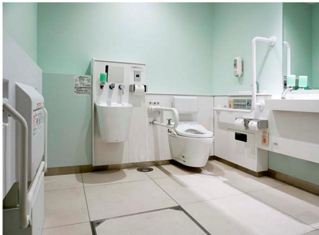
バリアフリーへの配慮から、コンパクト多機能トイレパック(車いす・オストメイト対応セット)を設置。そのほか、大人が横になれるサイズの収納式多目的シートを採用している。
