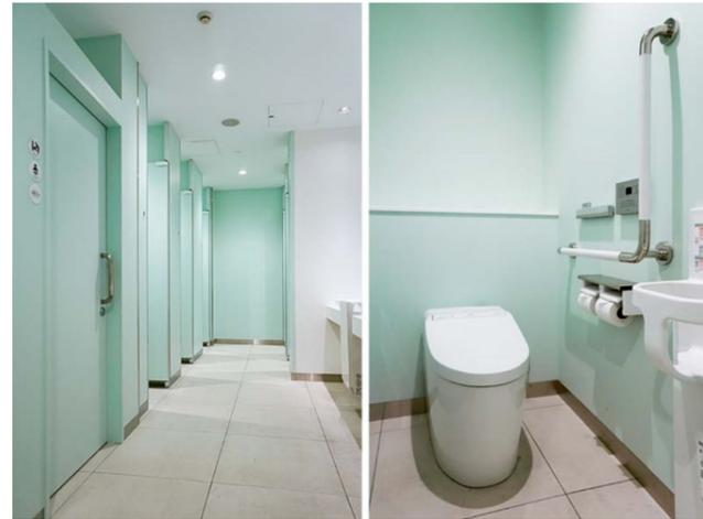
今回の改修ですべて洋式便器に変更。大便器は節水性に優れた4.8L洗浄のネオレストDHと、意匠性の高いスティックタイプのリモコンを採用。また、男女とも全ブースにベビーチェアと手すり、擬音装置を設置。
