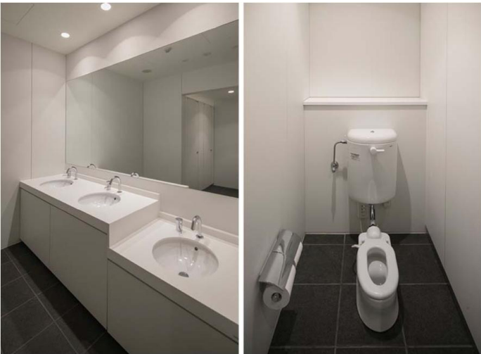
男女別なく子育てに取り組む近年の傾向に対応し、1Fの男性トイレ・女性トイレにはそれぞれ「キッズトイレ」(幼児用大便器ブース)を設置。洗面器の内1ヶ所はお子様の使いやすさを考慮して低めにしている。
