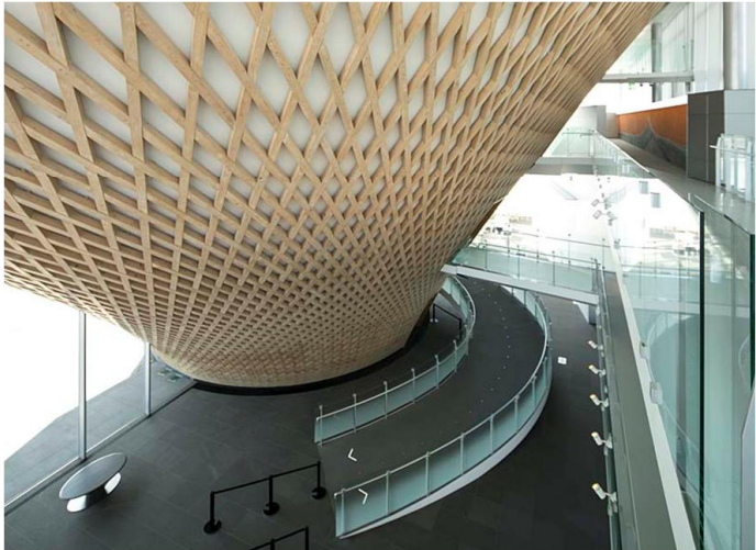
高さ14mの逆円錐型の木製格子壁は、ガラス張りの内部にも連続する。4層吹き抜けのアトリウムでは、大迫力の構造体を間近に見られる。
