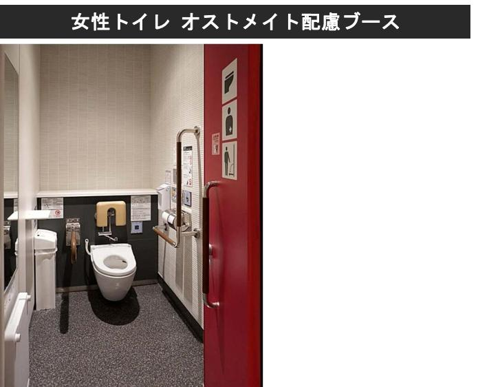
男女トイレの1ヶ所には、パウチ・しごん洗浄水栓付背もたれを設置したオストメイト配慮ブースを設け、多機能トイレの機能分散を図っている。
