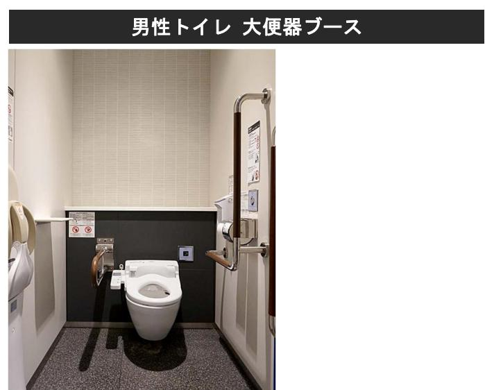
高齢者、障がい者の使いやすさに配慮して、すべての大便器ブースにL型手すりとはねあげ手すりを設置している。ブースサイズは大きな荷物を持ち込みやすいように、幅1200mm × 奥行き2000mmを確保している。
