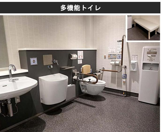
多機能トイレは便器や手洗器、簡易ベッドに干渉せずに車いすが回転できるよう3000mm × 2700mmのサイズを確保している。
