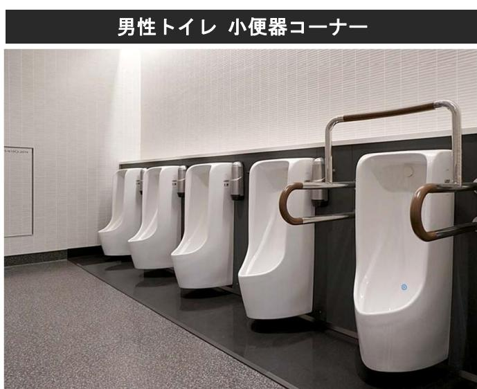
小便器は床の清掃性や節水性に優れた壁掛式の自動洗浄小便器を採用。1ヶ所には手すりを設置している。
