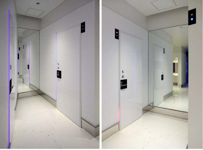
男女トイレのブースには、青色(空いている)と赤色(使用中)のインジケータを表示。入室後、赤色の帯が30秒単位で上昇し、ブースを使用している時間がわかるようになっている。
