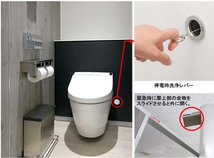
大便器ブースには、男女共に停電時でも水が流せるよう、停電時洗浄レバーが設置されている。またブース扉は、緊急時外開きが可能になる機構を備えており、安全面でも極め細やかな配慮がされている。
