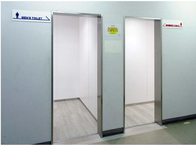
改修前のトイレ入口には扉が設置されていたが、限られたスペースでの利用しやすさと非接触を考慮し、内部への視線に配慮しながら扉なしのレイアウトに変更。
