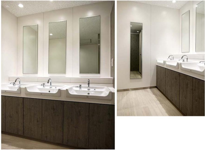
手を差し込みやすい深型タイプの洗面ボウルは、水はねを抑制。照明はLEDダウンライトの採用で、明るく気持ちが良い、リフレッシュできる空間を実現。自動水栓は停電時でも利用可能な自己発電タイプを採用。
