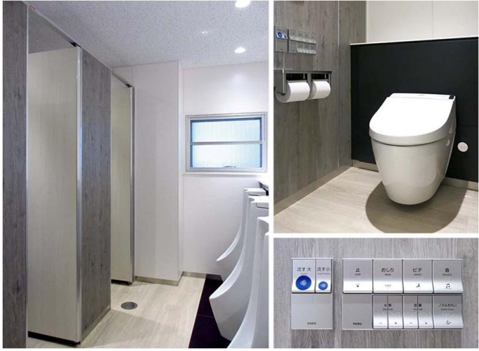
既設の窓を活かし、外光を取り入れた明るい空間。大便器は、床面から70mmのスペースが確保され、清掃性に優れたフラッシュタンク式壁掛タイプ。操作リモコンは、電源不要の自己発電タイプを採用。
