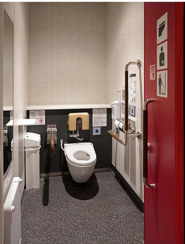
男女トイレの1ヶ所には、パウチ・しびん洗浄水栓付背もたれを設置したオストメイト配慮ブースを設け、多機能トイレの機能分散を図っている。
