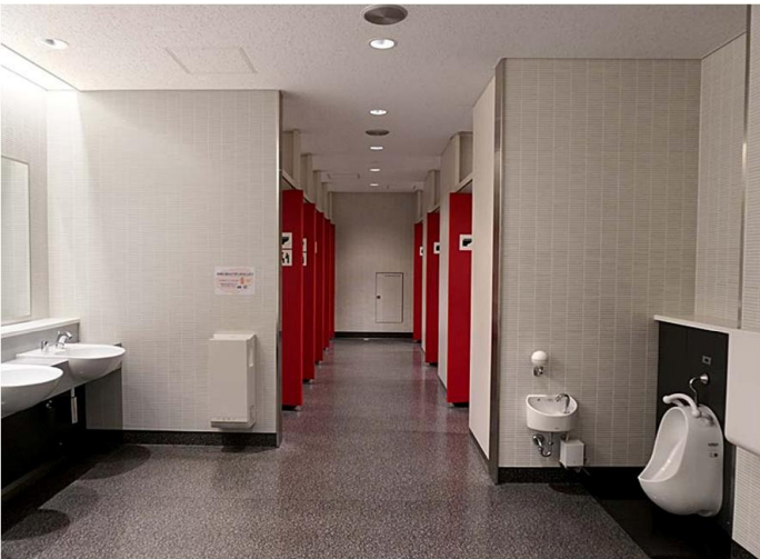
白を基調に赤い扉がアクセントを加えている明るく清潔感のあるトイレ空間。お子様連れ利用者への配慮として、ベビーシート、幼児用小便器、あふれ面高さの低い手洗器を設置している。
