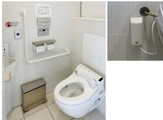
男女トイレすべてのブースにウォッシュレットを設置し、外国人観光客に配慮して、多国語表記の使い方をラベルを掲示している。いたずら防止用のコンセントカバーも取り付けている。
