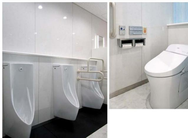
床の清掃性や節水性に優れた壁掛式の自動洗浄小便器。ウォシュレット一体型便器には、押すたびに発電するエコリモコンを採用。お子様連れに配慮し、ブース内にはベビーチェアも完備されている。
