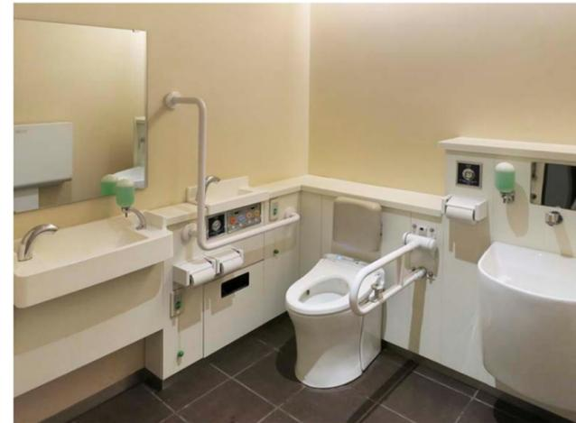
さまざまな利用者を想定して、各フロア3ヶ所ずつ多機能トイレを設置。コンパクト多機能トイレバックを採用、大型ベッドやベビー配慮器具など、トイレごとに異なる器具を設置し、機能分散化を図っている。
