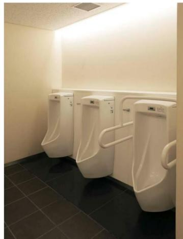
床の清掃性に優れた壁掛け式の自動洗浄小便器を採用し、1ヶ所は、立位保持のための手すりを設置。荷物配慮として、小便器の間に傘や荷物が掛けられるフックを設けている。
