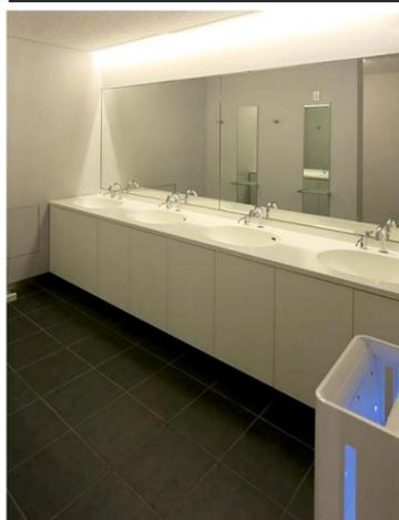
白を基調とした清潔感のある洗面スペースは、衛生面に配慮して非接触で水の出しとめができる自動水栓と自動水せけん供給栓を採用している。
