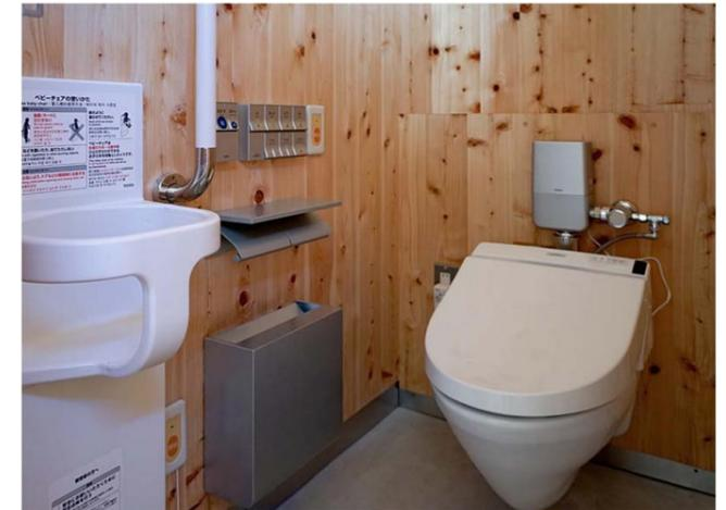
防犯や安全対策として、非常ボタンを設置。緊急時には、トイレ入り口に設置している表示灯と呼出音で、ブースや施設外に知らせるしくみとなっている。
