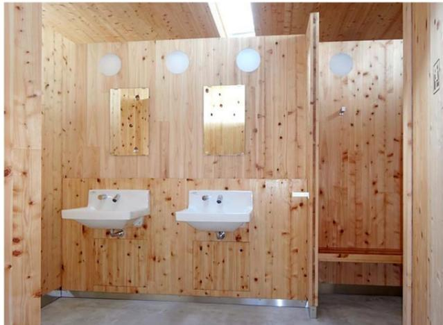
床の清掃性を考慮し、壁掛ハイバック洗面器を選定。水栓金具も壁付で、センサーで感知するノンタッチ方式を採用。トイレ空間の清潔さを保つように配慮された器具が選ばれている。
