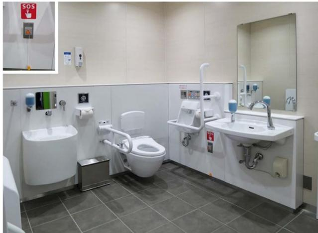
ライニングユニットの車いす対応トイレパックを採用。さまざまな利用者を想定して、汚物流しや多目的シート、ベビーチェアを設置。緊急時呼び出しボタンには、上部にサインを表示し、誤作動防止をしている。
