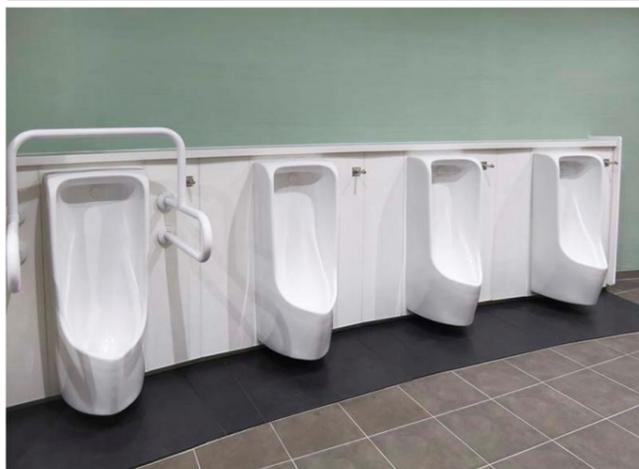
床の清掃性や節水性に優れた壁掛式自動洗浄小便器を採用。荷物配慮として、棚やフックを設けている。小便器の足元には、尿の飛散によるにおいや汚れを軽減するハイドロセラ・フロアを採用。
