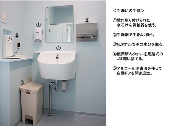
手洗いの一連の動作が非接触となるよう工夫し、衛生性の強化・徹底を実現。手洗器は、ラクな姿勢で、無理なくヒジまで洗えるスタッフ用手洗器を採用。
