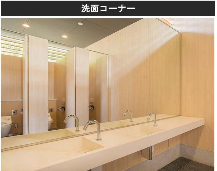
洗面カウンターは、洗面ボウルとカウンターに継ぎ目がなく、清掃しやすいボウル一体型カウンターを設置。水栓は、非接触で水の止め忘れがない自動水栓を採用している。
