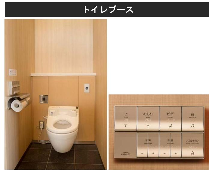
紙の削減や宗教信仰上、水洗い式文化圏の訪日外国人などに配慮し、全ブーストイレに温水洗浄便座を設置。リモコンはボタンを押すたびに発電する電源工事不要の「エコリモコン」を採用している。
