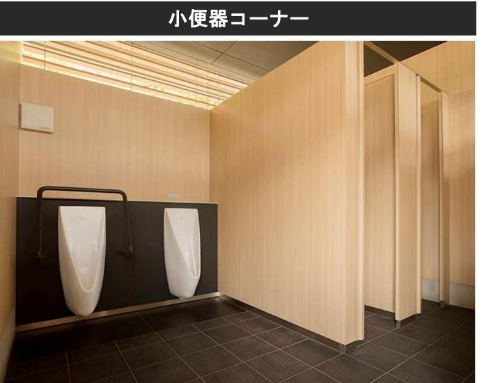
節水型であり、尿石の付着やにおいの発生を抑制することができるジアテクト機能付き自動洗浄小便器を採用。足元には、尿の飛散によるにおいや汚れを軽減するハイドロセラ・フロアを設置している。
