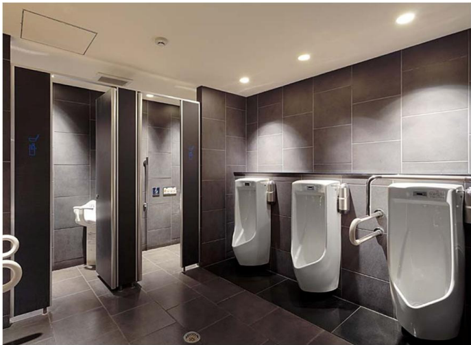
男性トイレ 全景
