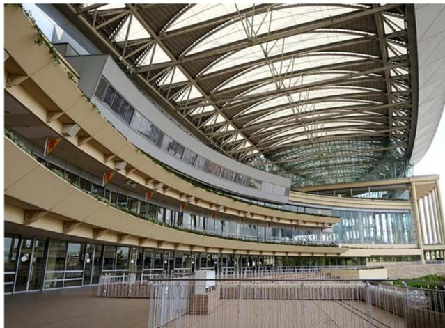
モノレール駅と直結し、アクセスに優れた小倉競馬場。パドック観客席屋根は1999年の竣工。幅50m全長90mの壮大な張弦梁と膜構造となっており、圧巻の大空間となっている。
