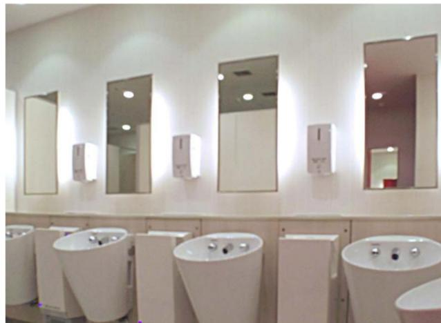
周囲への水はねを防ぐ形状の壁掛自動洗面器を採用。洗面器の間にハンドドライヤーを設置し、手洗い後の床への水垂れも抑えている。
