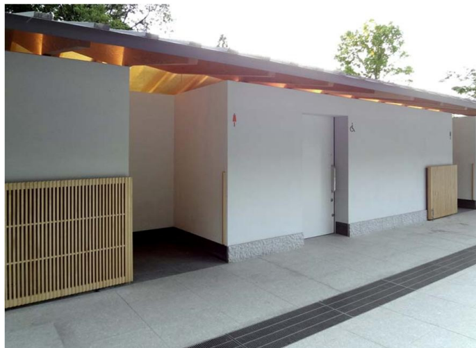
軒桁をなくすことで、壁と屋根の間に隙間が生まれ、外気の気持ちよさを感じられる工夫が施されている。トイレ入口には、オリジナルのサインを掲示している。
