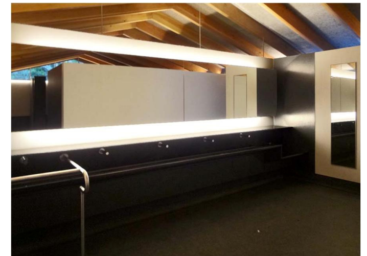
鏡裏の間接照明が落ち着いた雰囲気を出している。水栓は壁付の自動水栓を採用し、清掃性と利用者の快適性に配慮している。
