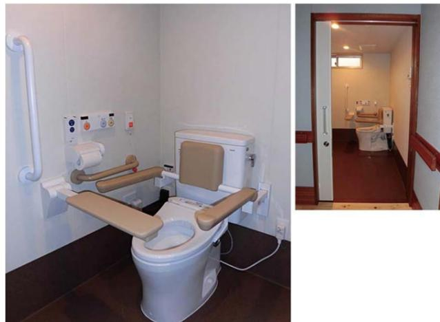
便器詰まりに配慮して掃除口付便器を設置。ウォシュレットのリモコンは、介助者の使いやすさを考慮して高めの位置に設置し、便器横方向からのアプローチがしやすいように入口は後方に設けている。
