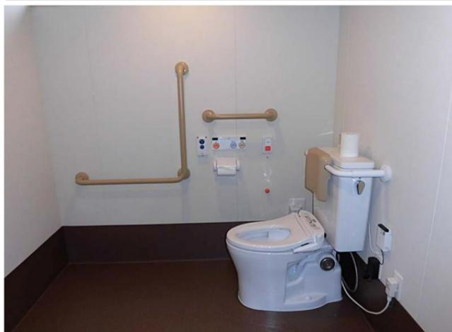
手すりの設置は、車いすから便器に移乗する際にL型手すりの横部分、便器からの立ち上がりが高い位置の横手すりを使うという検証結果を反映。Aユニットと同様、便器詰まりに配慮した掃除口付便器を採用。
