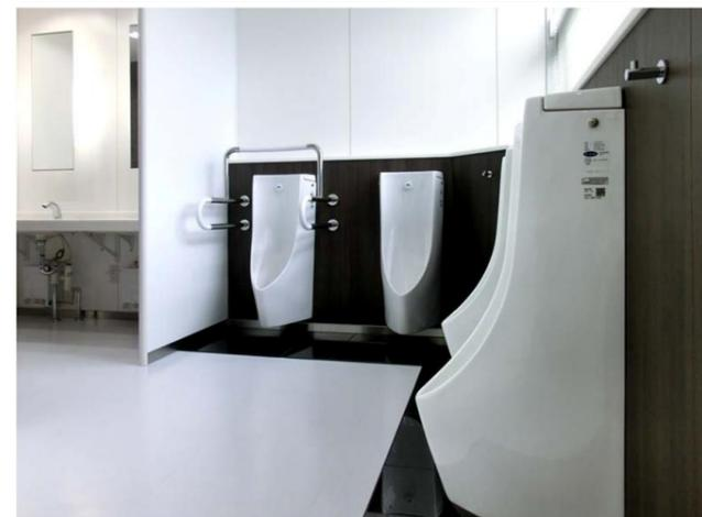
自動洗浄小便器は、電源不要の自己発電タイプを採用。足元には、尿の飛散によるにおいや汚れを軽減する、ハイドロセラフロアを設置している。
