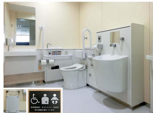
多目的トイレは、必要な設備がパッケージされたコンパクト多機能トイレパックを採用。お子様連れにも配慮し、フィッティングボード、ベビーチェア、ベビーシートも設置。1Fとは左右反転のレイアウトとしている。
