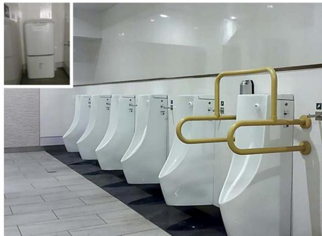
シンプルデザインと節水性能を両立する、壁掛自動洗浄小便器を採用。お子様を連れた男性の利用者が、ベビー休憩室以外でもおむつ交換ができるように、入口側にベビーシートを設置している。
