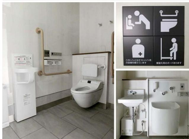
多機能トイレの混雑の緩和を図るため、オストメイトや、子ども連れ配慮の機能を男女トイレに分散させた。オストメイト対応トイレパックのほか、ベビーチェアやフィッティングボード、小型手洗器を設置している。
