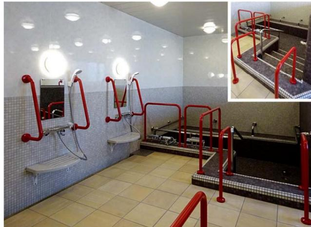
入浴中の安全と介助しやすさへの配慮から、洗い場や浴槽への出入り口など要所に視認性のよい赤色の手すりを設置。浴槽のフチや段差も、タイルの配色によりコントラストを強調し、より安全性を高めている。
