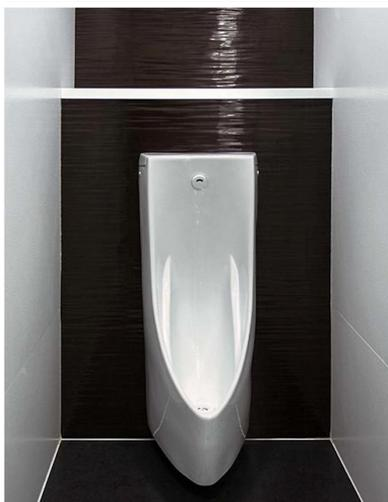
大便器と同様、壁掛式の小便器を設置。におい対策と清掃性の向上を目的に、床面・壁面・ライニングの前面にハイドロテクトタイルを採用している。
