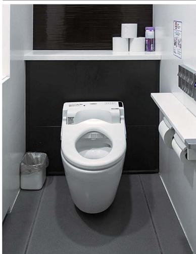
大便器ブースには清掃性の向上を目的に壁掛大便器を設置。床面・壁面には、光触媒の抗菌効果により汚れやにおいの発生をおさえるハイドロテクトタイルを設置。
