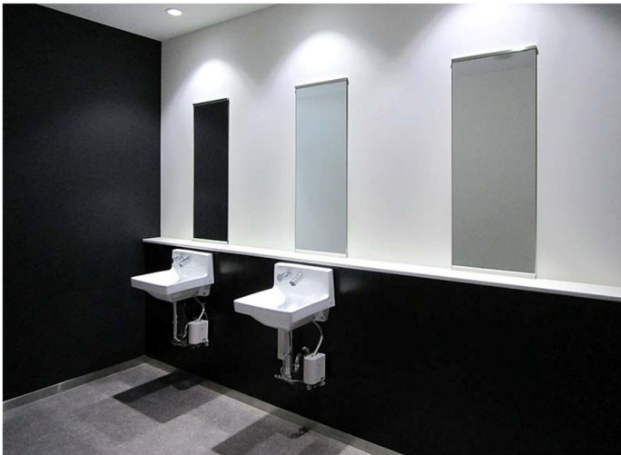
女性トイレ 洗面コーナー
