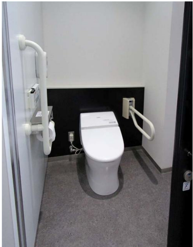
男性トイレ 大便器ブース
