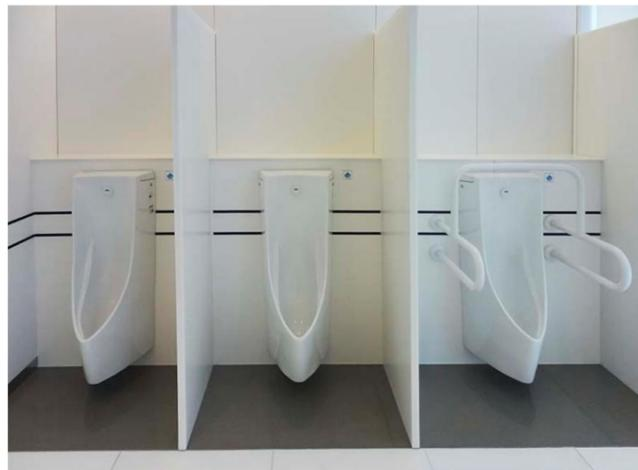
小便器は、床の清掃性に優れた壁掛式の自動洗浄小便器を採用。ジアテクト機能搭載で、尿石の付着やにおいの発生を抑制できる。プライバシーに配慮し、小便器の間には全身をカバーする仕切りを設置。
