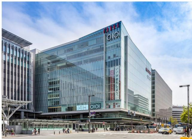
博多駅を中心とした都市空間との景観の調和に配慮した外装デザイン。ガラスカーテンウォールのバックパネルを傾斜させることで博多織をイメージした市松模様を表現している。日没後には演出照明により光の外装をまとい、商業施設としての賑わいを演出している。
