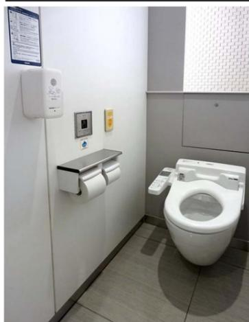
使用頻度が高いことから、特に清掃性に配慮し、給水ホースなどが露出せず、掃除がしやすい壁掛大便器を設置。
