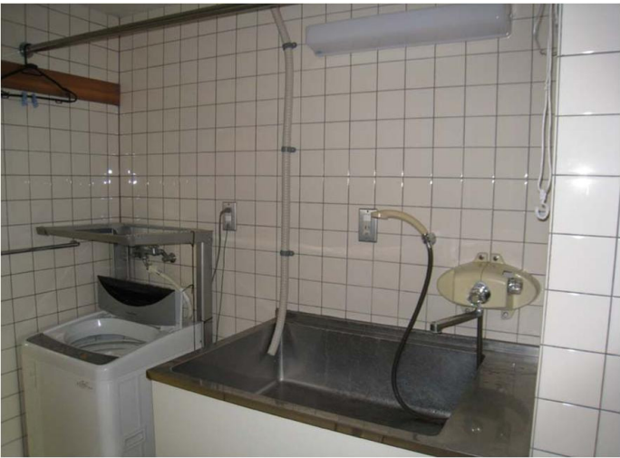
沐浴室（改修前）
