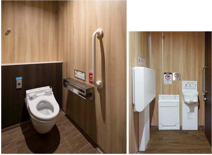
女性トイレ ひろびろブース
