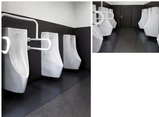
シンプルデザインと大幅節水を実現した壁掛式の自動洗浄小便器を採用し、1台には専用手すりを設置。小便器の足元には尿の飛散によるにおいや、汚れを軽減するハイドロセラ・フロアPU(薄型)を設置。
