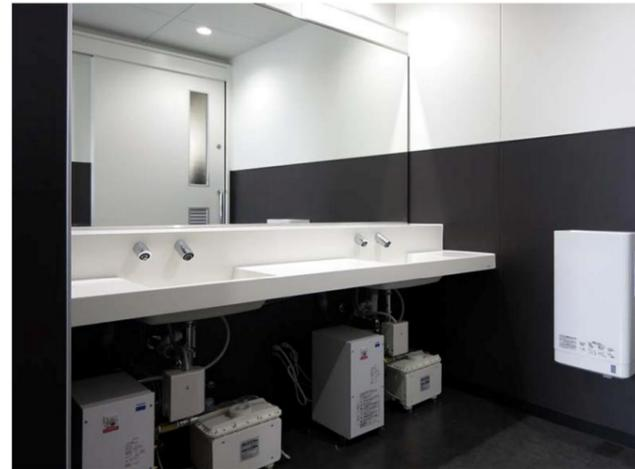
水濡れを心配せずに化粧ポーチなどの小物を置くことができるように、ツインデッキカウンターを採用。自動水栓・電気温水器・オートソープディスペンサー・クリーンドライを設置し、快適性を向上させた。
