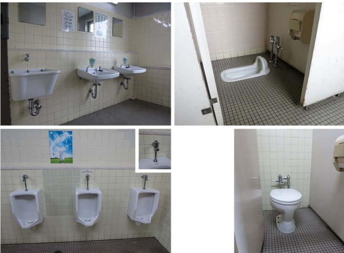
5F トイレ改修前
