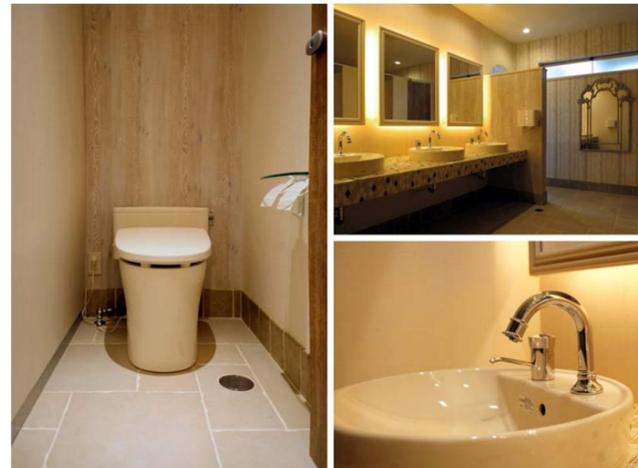
大便器はトイレ空間と調和するように陶器色に、パステルアイボリーを採用。洗面コーナーでは、デザイン性に優れた丸型のベッセル式洗面器を、タイルでデザインされたカウンターの上に設置している。
