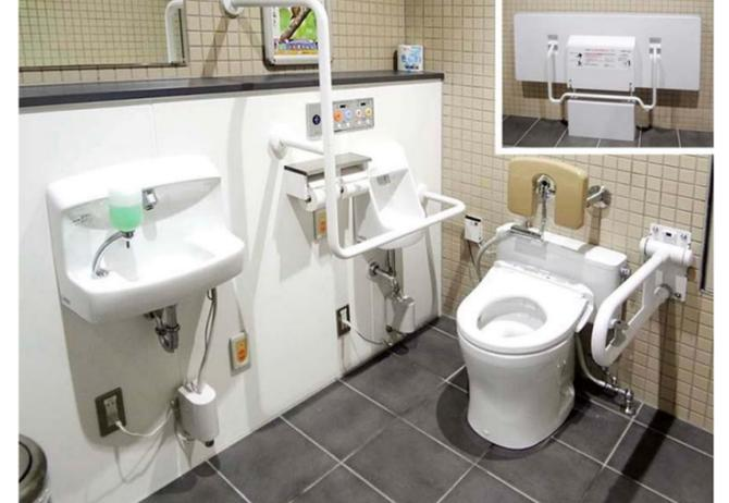
さまざまな身体状況の方に配慮して、収納式多目的シートを設置。また、オストメイトに配慮し、パウチ・しびん洗浄水栓付背もたれを設置している。
