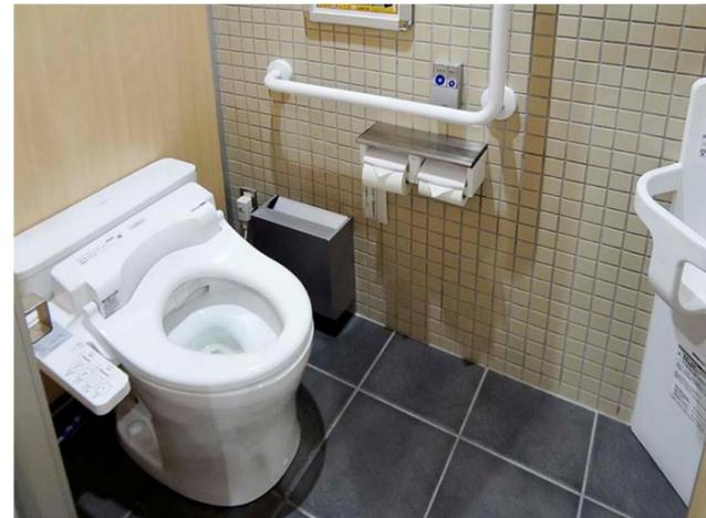
大便器は、節水性の高いパブリックコンパクト便器フラッシュタンク式を採用。プライバシーの確保と2度流しを減らすことで節水に繋がる音姫(擬音装置)機能を搭載した、ウォッシュレットPを設置。
