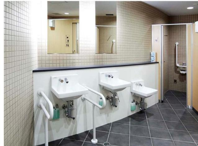
洗面器は、鏡との距離が近く、お化粧直しがしやすい壁掛ハイバック洗面器を採用。洗面器の内1ヶ所はお子様の使いやすさを考慮して低めに設置している。
