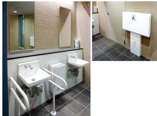
洗面器の水栓金具は、ノンタッチで水の出し止めができる壁付自動水栓を採用。お子様連れに配慮し、男性トイレ内にも、ベビーシート(おむつ交換台)を設置している。
