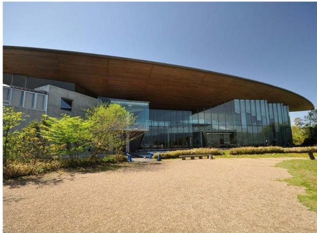
比良山地を背景に、琵琶湖畔の烏丸半島に位置。ロビーやレストランなどのパブリックスペースの上部に、丸子船の船底をイメージした三日月型平面大屋根を架け渡して、おらかな広がりを感じさせる。
