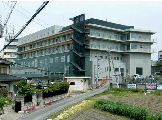
島田病院は、大阪府の南東部に位置する羽曳野市にある整形外科専門病院であり、今回新たに地域包括ケア病棟を持つことになった。
