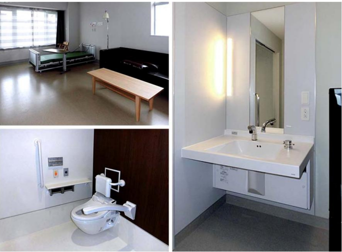
トイレ・洗面・浴室・ミニキッチンを設けた特別室。トイレには、転倒防止策として背もたれとアームレスト、I型手すりと棚付二連紙巻器を設置。洗面化粧台は、いすに座ったまま使える座ってラクラクシリーズを採用。
