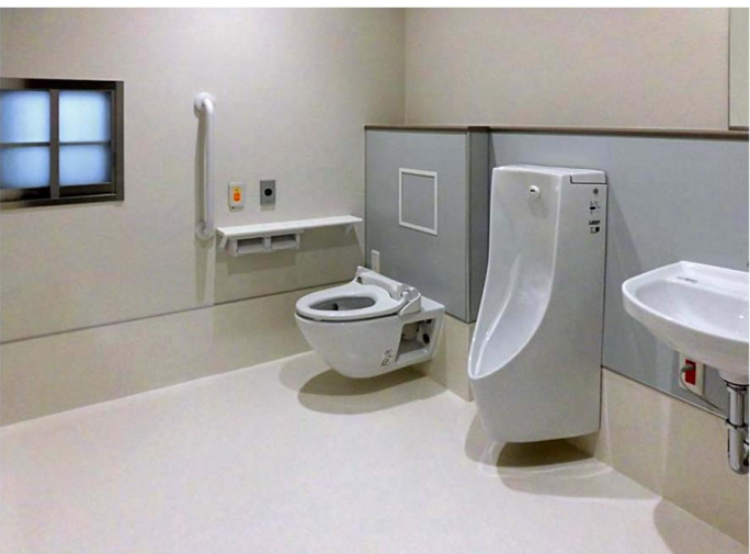
壁に採尿用の窓を設けた、検査室に隣接した共用トイレ。男性の採尿に配慮し、小便器も設置している。
