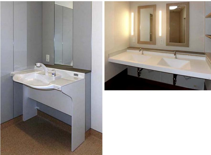
機械浴室には、車いす使用者や介助者の使い勝手に配慮した車いす対応洗面を採用(左)。個別浴室には、カウンター式洗面を採用。パウダーコーナーを兼ねており、照明を鏡横に設置し、鏡映りに配慮(右)。
