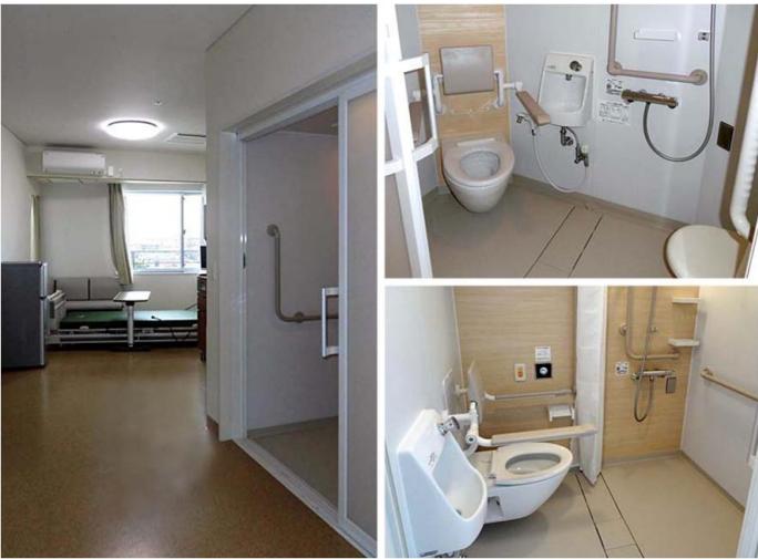
病室の形状やスペースに合わせて、個室の水まわりには、病院用ユニットバス(大便器は壁掛け特注仕様)、またはオクタゴン(病院・高齢者施設向ユニット)を配置している。
