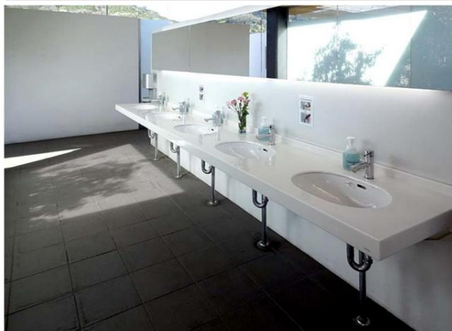
明るく開放的な洗面コーナー。水栓は、操作レバーの水と湯の境に設けたクリック感で、湯水をきちんと使い分けられるエコシングル水栓を採用。
