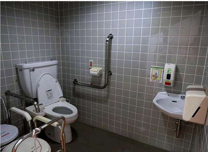
療養室フロア共用トイレ 改修前
