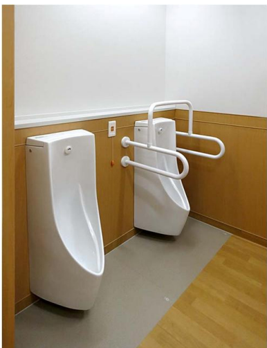
1F共用男性トイレ 小便器コーナー
