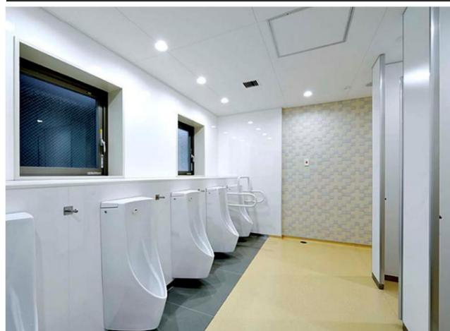
シンプルデザインと大幅な節水を実現した自動洗浄小便器を採用。従来よりもライニングが低く、荷物が置きやすい。手荷物配慮として、小便器間にもフックを設置している。
