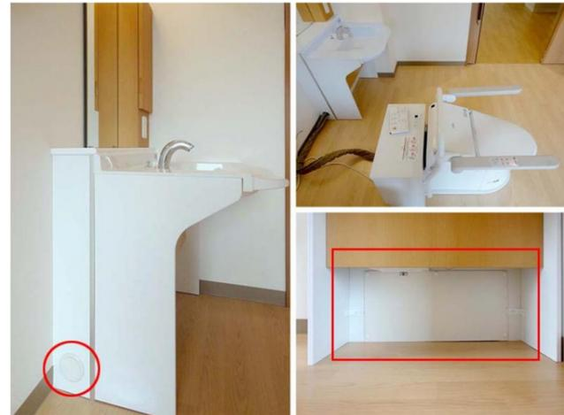
全居室に可動式のベッドサイド水洗トイレを後付けできるよう、接続口を完備。点検口は目立たないように洗面台の足元スペースを工夫した。
