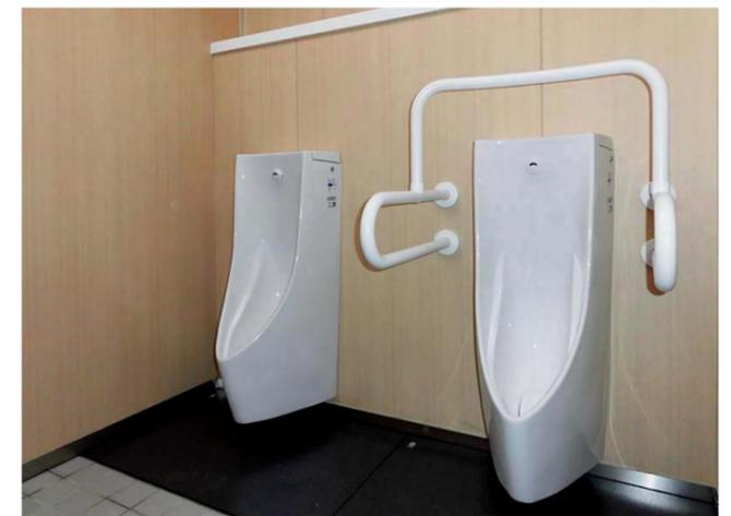
小さなお子様から大人まで使いやすい低リップタイプの小便器を採用。1ヶ所は、立位を安定させる専用手すりを設置。足元には尿の飛散によるにおいや、汚れを軽減する、ハイドロセラ・フロアを採用している。
