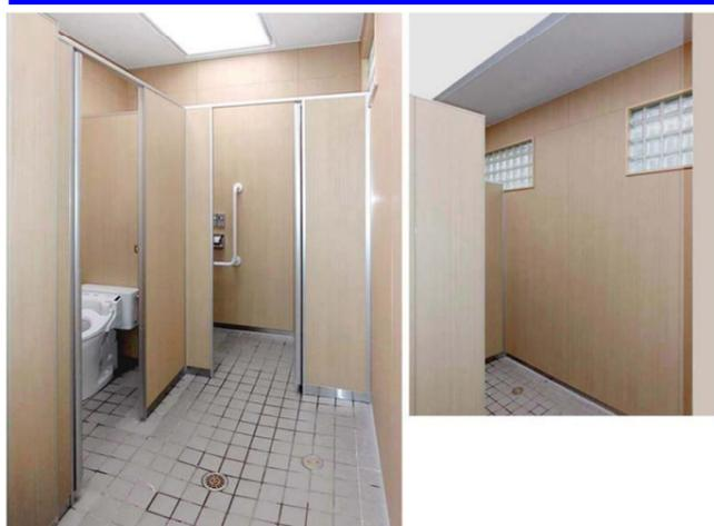
壁面はメンテナンス性を考慮し、従来の目地が多い100角タイルから明るく衛生的な不燃パネルに変更。従来のトップライトから、照度をアップした天井部の照明器具により、薄暗い印象を払拭した。
