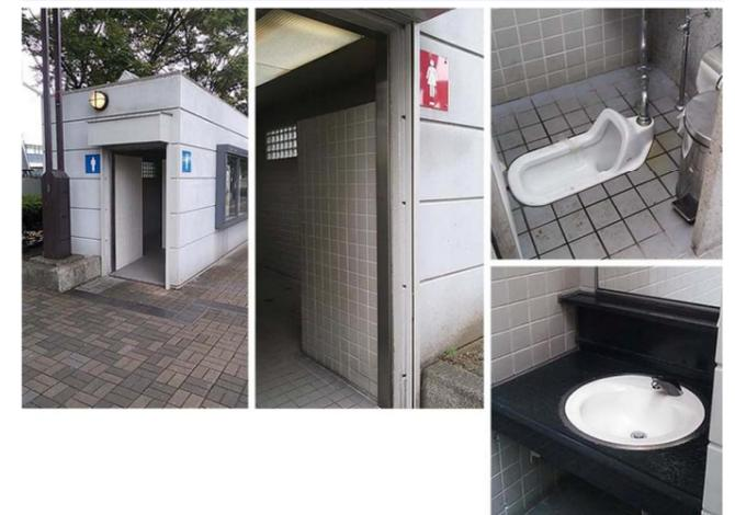
従来のトイレ棟外壁は、屋外設置によりチリ・ホコリや汚染物質などの汚れが付着し、白い外壁に黒ズミが目立ち、大便器は和式便器で、トイレ空間は薄暗く不衛生な印象で立ち上るにおいが気になっていた。
