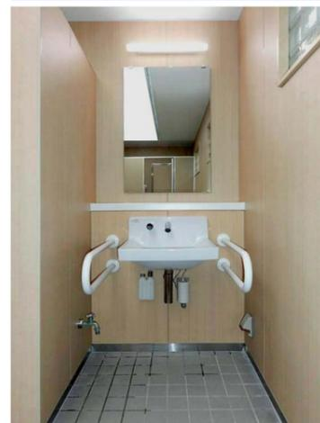
洗面コーナーに設置された水栓金具は、水じまいのよい壁付き自動水栓に衛生性に配慮して水石けんを設置。洗面姿勢を保持するための手すりも設置されている。
