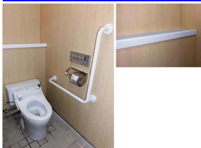
節水性とデザイン性に優れた、4.8L洗浄のパブリックコンパクト便器・フラッシュタンク式を採用。ウォシュレットのリモコンは電源不要のエコリモコン。荷物棚の手前を立ち上げた、手荷物の落下を防ぐ仕様。
