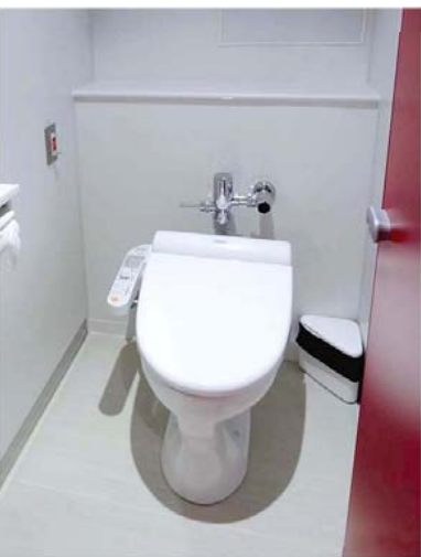
女性トイレ 大便器ブース
