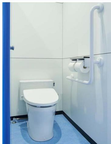
大便器は、フラッシュバルブ式同様連続洗浄ができる、パブリックコンパクト便器・フラッシュタンク式を採用し暖房便座を設置。1ヶ所の大便秘器ブースには、L型手すりを設置している。
