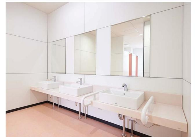
テーマカラーのピンクがすがすがしい印象の床面。洗面器はデザイン性に配慮しベッセル式を採用。洗面器のあふれ面高さは、学年に応じて600mm・650mm・700mmと高さを変えて設置している。
